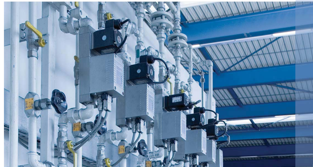
Рис. 9: Регуляторы массового расхода газа используются в воспроизводимых процессах. Объем атмосферы может простирается от точечной области в зоне сварного шва до объема камеры печи для термообработки.
